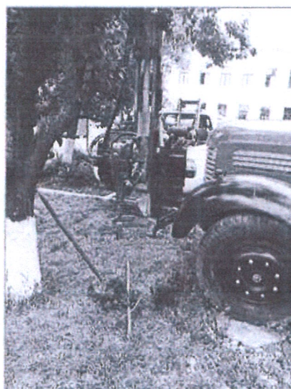
Foto 1. Aspectul terenului investigat și instalația de foraj geotehnic utilizat
