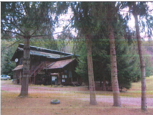
VEDERE SPRE N-V
